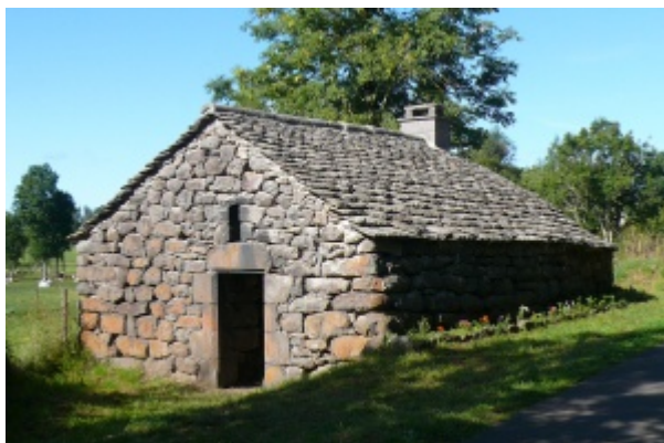
Four à pain dans le Cantal
