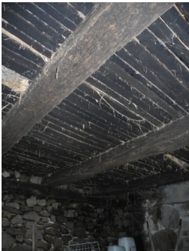
Plancher à claire-voie à l'intérieur d'un sécadou.
