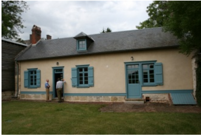
Maison à Hallivillers (Somme). Le toit est couvert d'ardoise et le solin est en grès avec un larmier le protégeant du ruissellement.
