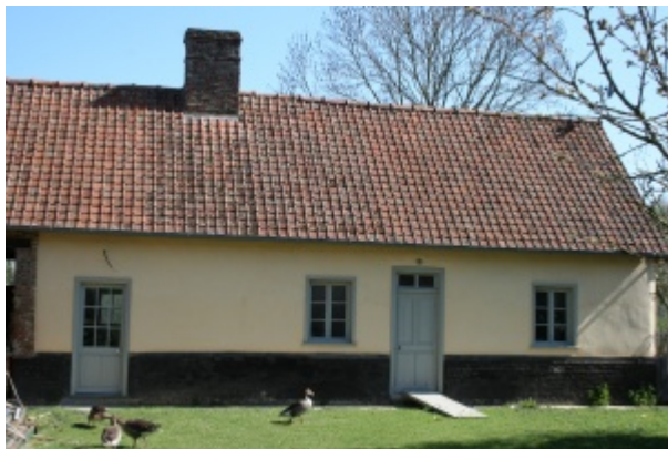
Maison à Mons-Boubert avec soubassement en briques peint en noir et couverture en panne picarde.
