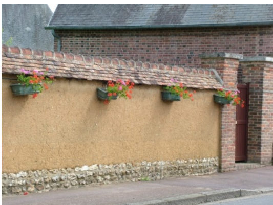
Taille au bâton d'un mur en bauge. Photo François Streiff, Parc Naturel Régional du Marais du Cotentin et du Bessin ©
