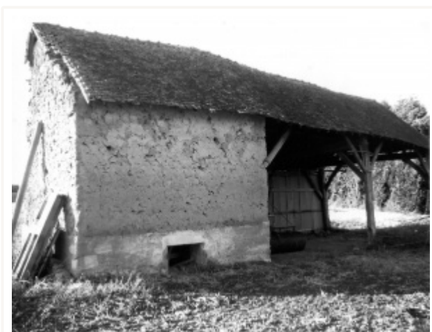
Dangeul, la Croix Rouge, four à chanvre carré en bauge. Détruit dans les années 1990 et remplacé par un hangar. Photo Serge Bertin.
