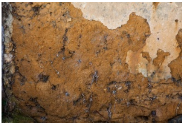
Avezé, la Mussardière, détail du mur en bauge et de ses vestiges d'enduit à la chaux. Photo CEMJIMA-Perche Sarthois, 2016.
