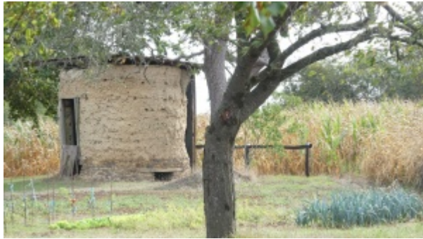
Souillé, la Chapuisière, four à chanvre. Photo Patrick Dejust - Maisons Paysannes de la Sarthe.
