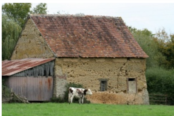
Grange en bauge à Vibraye - Photo Perche Sarthois - 2006.
