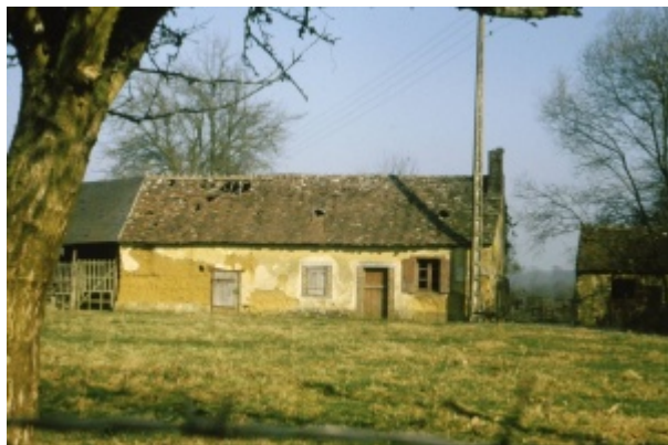
Bordage en bauge à la Croix Mignon, Sémur-en-Vallon. Photo Alain Rocheron - Maisons Paysannes de France.
