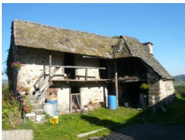
Bolet avec poulailler au rez-de-chaussée. Le toit est couvert de lauzes.
