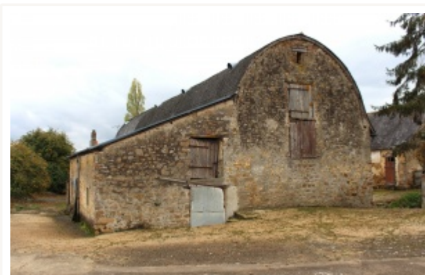
Le Pont de Vaiges à Sablé-sur-Sarthe - Photo Léo Cany.
