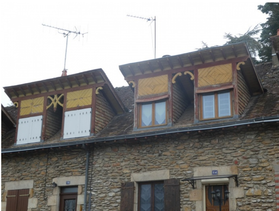
Chien-assis couplés deux par deux à Fresnay-sur-Sarthe (72). Photo P. Dejust © Maisons Paysannes de la Sarthe.
