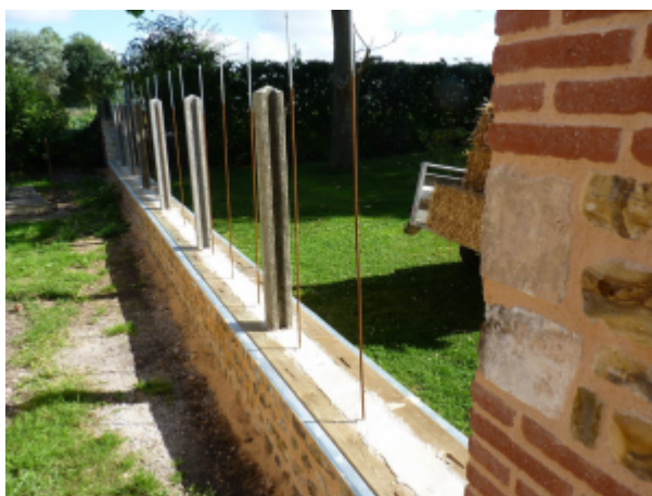
Soubassement du mur en paille.
