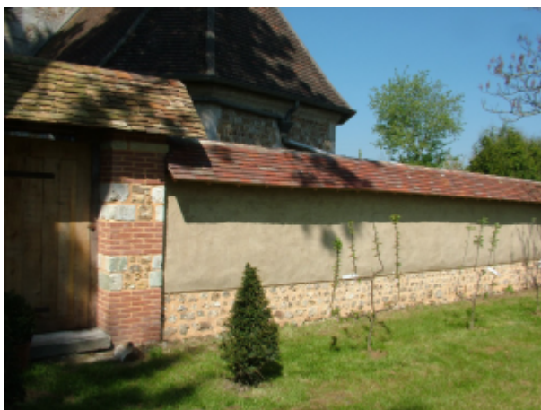
Mur de paille recouvert d'un enduit et couvert d'un chaperon.
