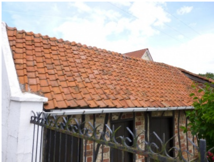
Couverture en pannes picardes
