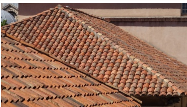
Toiture en tuiles canal avec vue sur arête, Centre de la Vieille Charité (Marseille)
