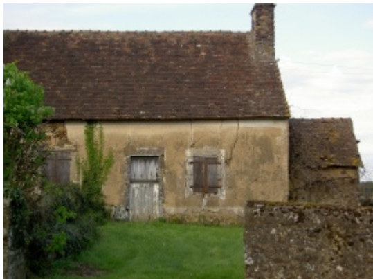
5 - Maison dont le soubassement est suggéré par un simple bandeau tracé à la chaux.
