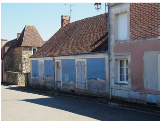
16 - Enduits de couleur à Saint-Denis-des-Coudray. Photo P. Dejust © Maisons Paysannes de la Sarthe.
