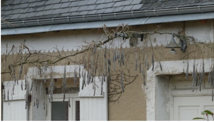
11 - Bandeau décoratif à Pruillé-L'Eguillé. Photo P. Dejust © Maisons Paysannes de la Sarthe.
