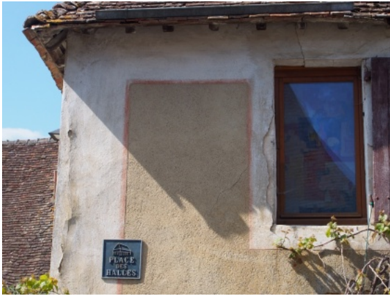
14 - Filet rouge accompagnant le bandeaux blancs à René. Photo P. Dejust © Maisons Paysannes de la Sarthe.
