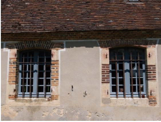
17 - Enduit gris clair, filet blanc, briques et pierres à Melleray. Photo P. Dejust © Maisons Paysannes de la Sarthe.
