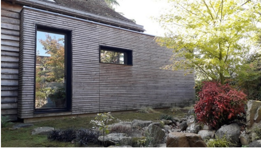
L'extension à l'arrière de la maison prend la place d'un ancien appentis.Photo Denis-Marie Lahellec © Maisons Paysannes de France, Délégation de la Sarthe.
