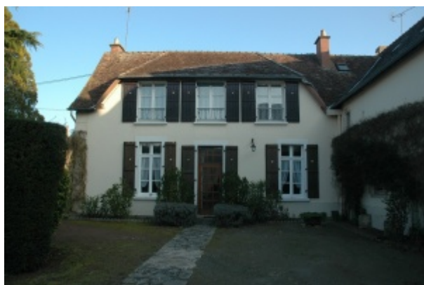
Façade principale avant travaux.
