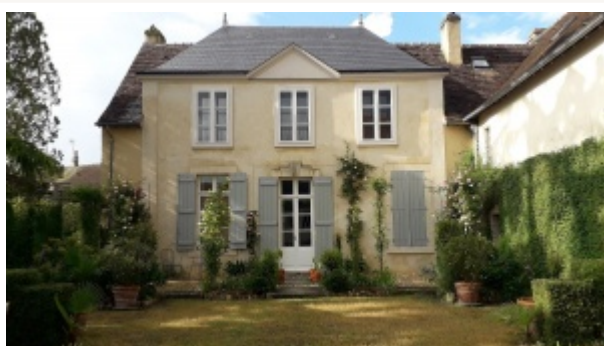
Façade du corps principal après travaux.
