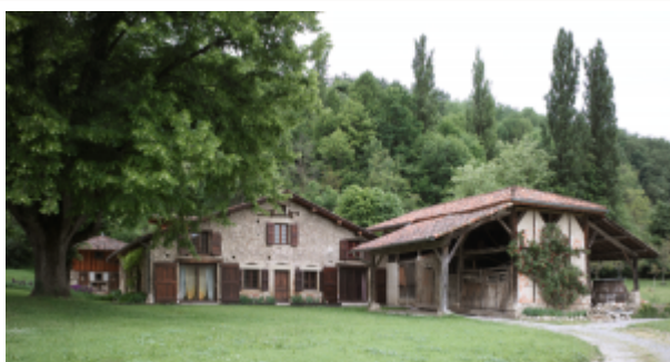
Ferme de la Galicière, vue d'ensemble.
