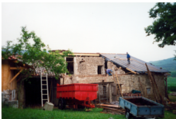
Façade sud pendant les travaux.
