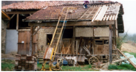
Préau pendant les travaux.
