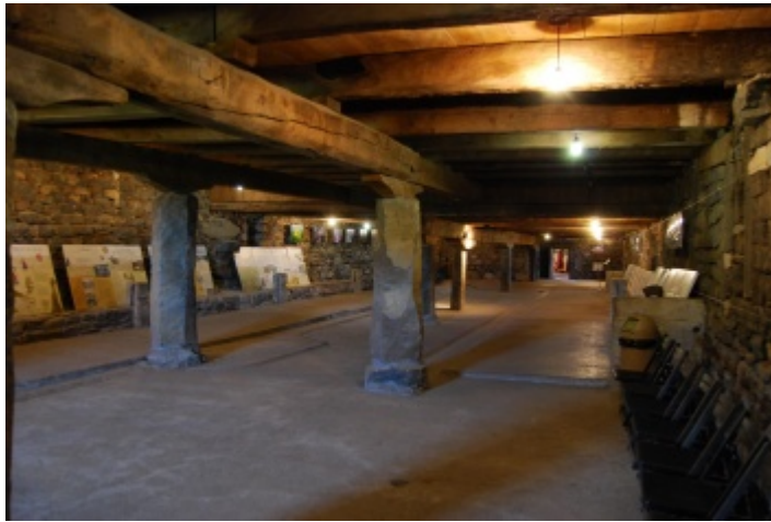
Intérieur de la ferme du Bourlatier avec deux rangées de poteaux pour soutenir deux chareyres, la charpente étant très grande et large.
