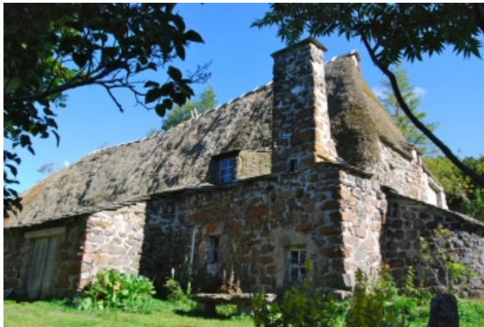
Ferme Philip couverte de genêt (Sainte-Eulalie) et avec l'arcas couvert de lauzes. La cheminée est déportée du genêt pour éviter d'éventuelles flammèches.
