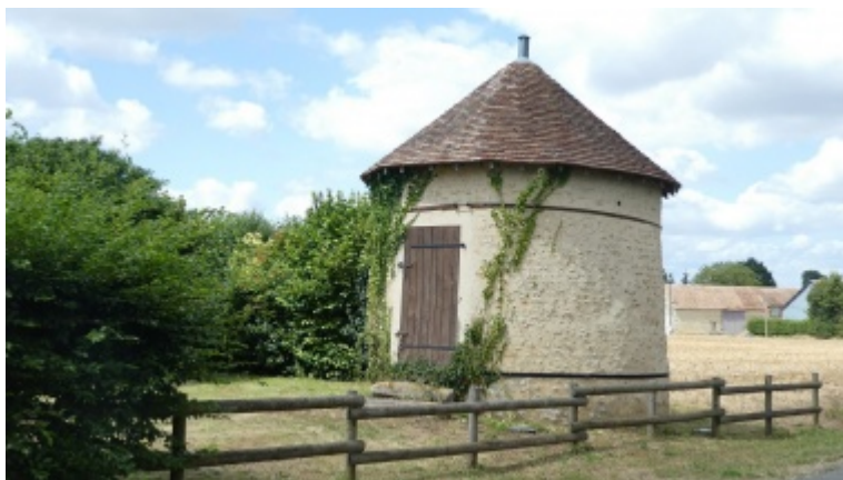
Four à chanvre à Doucelles. Deux cercles de fer renforcent la structure du four.
