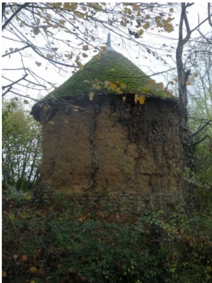
Four à chanvre avec murs en bauge à Vivoin.
