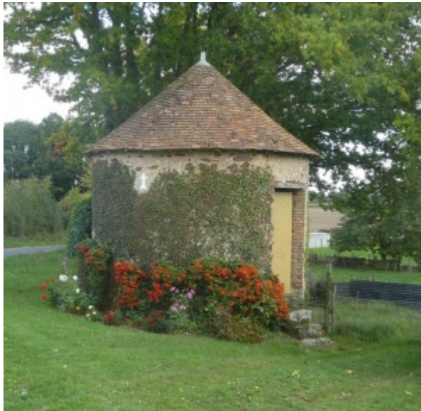
Four à chanvre situé à Les Bondés, Assé-le-Riboul.
