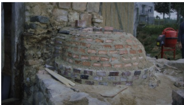
Voûte en brique du four à pain.
