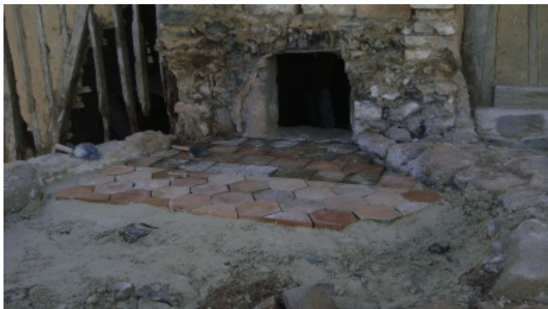
Surface plane de la sole avec carreaux posés sur un mortier. La bouche du four est déjà existante sur un des murs de la maison.
