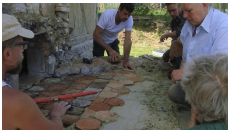
Pose de revêtement sur la sole du four.
