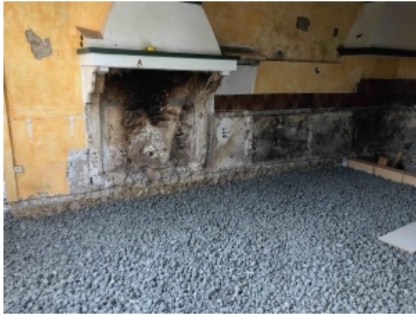
Hêrisson ventilé remplissage achevé.
