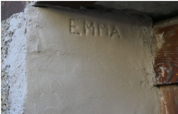
Résultat après application de l'enduit lissé. Le nom de la propriétaire qui a accueilli l'atelier est inscrit dans l'enduit. Photo Maisons Paysannes des Pays de Savoie © 2019.
