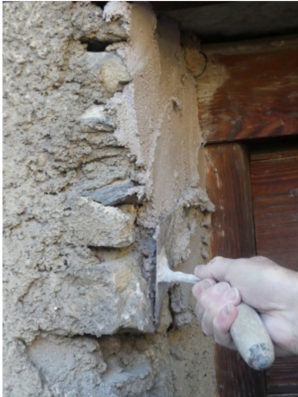
Application de la griya sur un mur en pierre.
