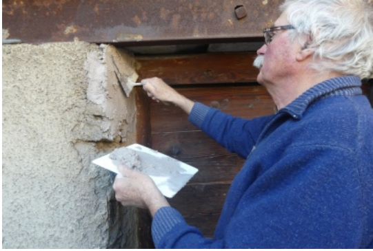
Application de l'enduit de griya tamisé. Photo Maisons Paysannes des Pays de Savoie © 2019.
