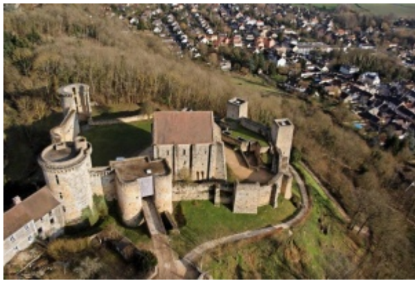
Château de la Madeleine avec intégration contemporaine du châtelet.
