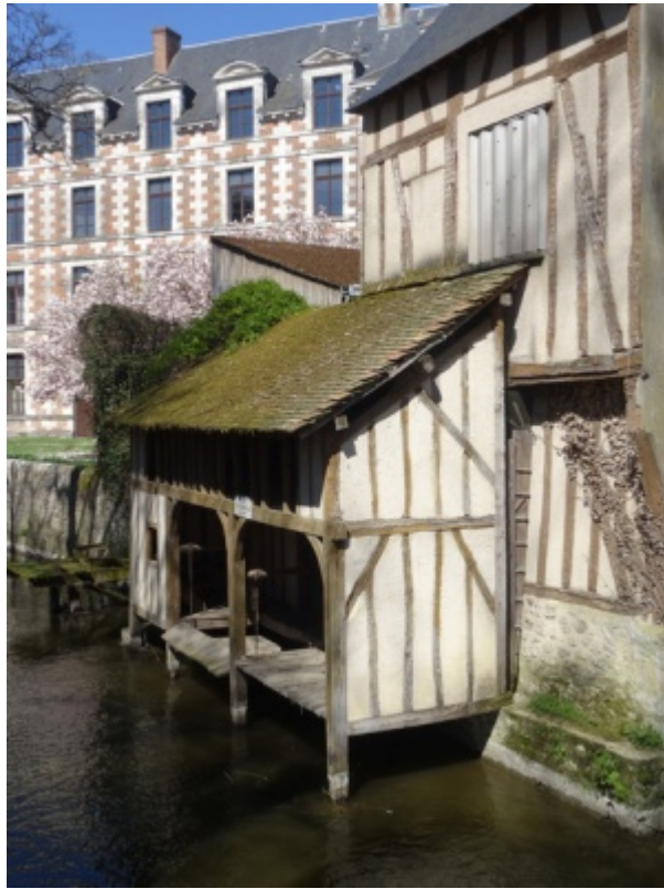
Lavoir des Cordeliers (construit dès la fin du XV ème siècle) donnant sur le Loir, Vendôme. La planche de lavage s'adapte au niveau du Loir.
