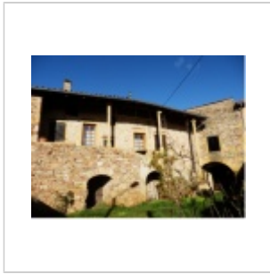
Aîtres à Saint-Laurent d'Oingt- Val d'Oingt 2.
