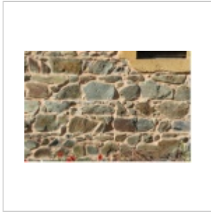
Légny-Pont Nizy - Appareil en roches variées.
