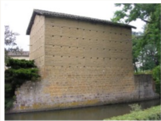
Bâtiment en pisé. Soubassement maçonné important pour éviter les remontées capillaires d'eau venant du ruisseau le bordant. On distingue nettement cinq étages de banches soulignés par les trous de boulins, passage des lassoniers ou serre-joints. © Photo P. Forissier
