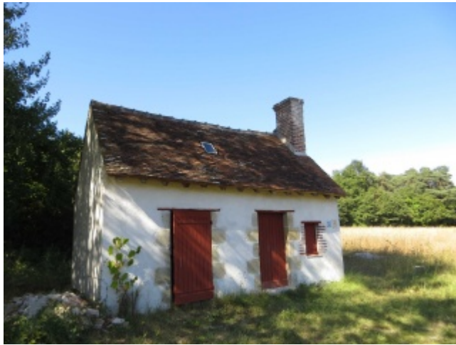
Loge de vigne après travaux de restauration, située à Mardié.
