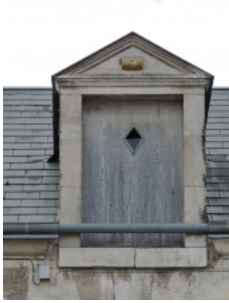
Lucarne avec décor en forme de tonneau. Photo Maisons Paysannes de France © Délégation du Loiret.
