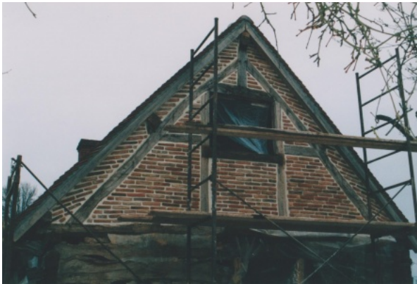
Hourdis brique entre pans de bois. Photo Maisons Paysannes de France ©
