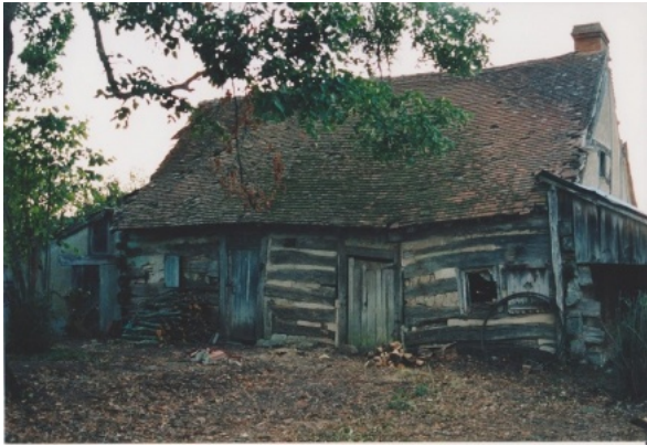
Maison à troncs couchés avant travaux à Thionne. Photo Maisons Paysannes de France ©
