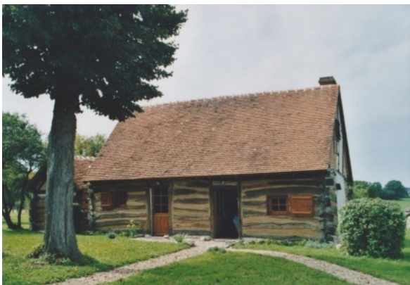
Maison à troncs couchés après restauration. Photo Maisons Paysannes de France ©
