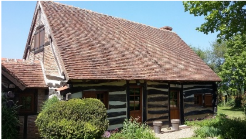
Maison à troncs couchés.
