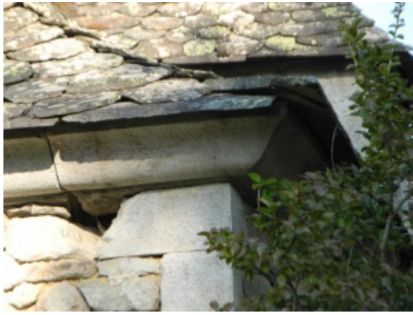
Doucine sous une toiture dans le Nord Cantal
