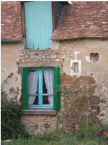
Niche avec encadrement peint à la chaux, située à Mézières-sous-Lavardin (72). Photo Alain Bardet © Maisons Paysannes de France, Délégation de la Sarthe.
