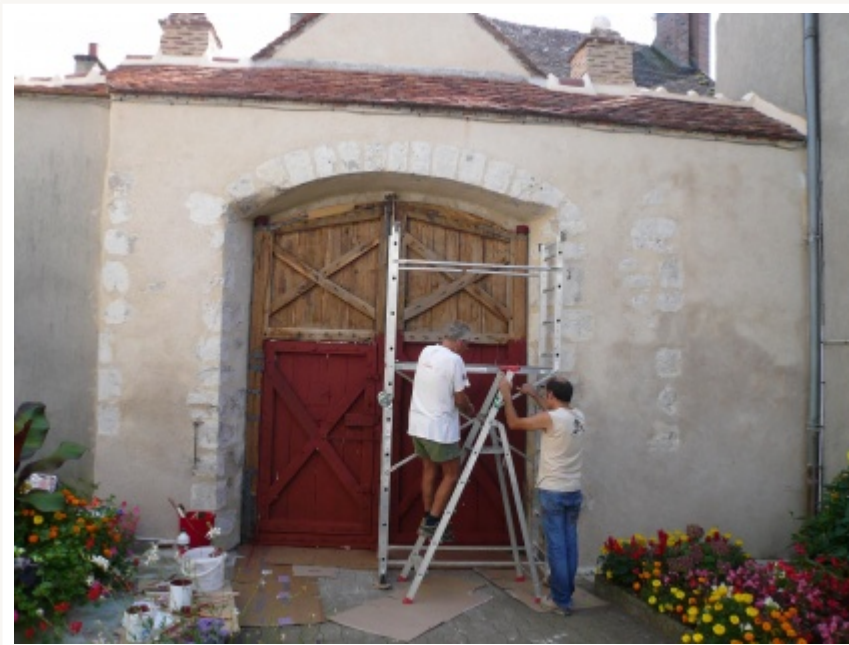
Application de peinture à l'ocre sur la porte en bois de l'Hôtel Dieu, Châtillon-Coligny (45).
