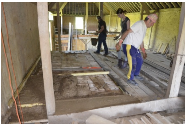
Application de terre sur barrelets. Photo Maisons Paysannes de Normandie © Délégation de l'Eure.
