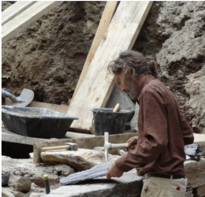
Taille de pierre sur place lors de la construction de la voûte du pont routier de Chaldecoste.
