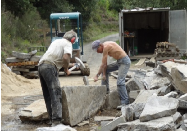
Artisans en train de dégrossir le bloc de schiste sur le chantier du Pont de Chaldecoste. Photo Maisons Paysannes de France - Prix René Fontaine ©
