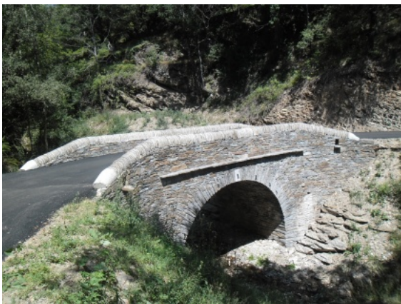
Pont avec ses parapets maçonnés à la chaux. Photo Maisons Paysannes de France - Prix René Fontaine ©
