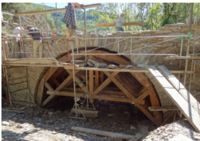
Décintrement de la voûte du pont.
