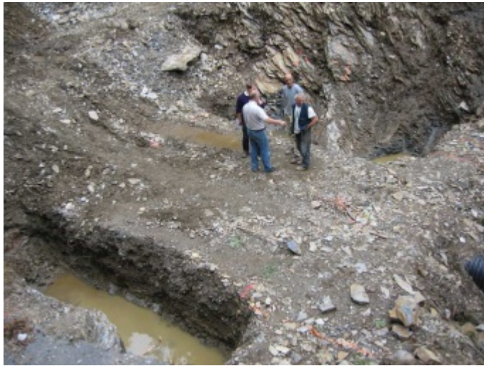
Site avant la construction des fondations du pont.
