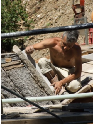
Mesure avant pose de la pierre pour la création de voûte du pont. Photo Maisons Paysannes de France - Prix René Fontaine ©
