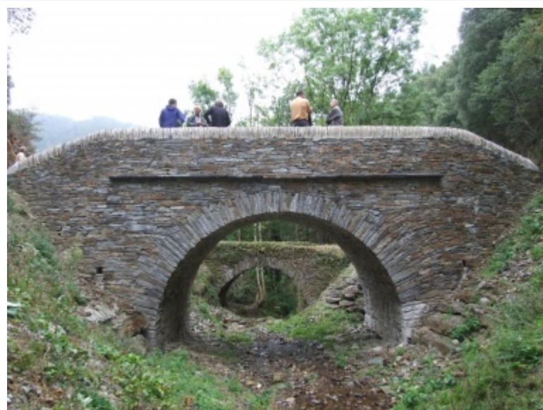
Pont routier de Chaldecoste.
