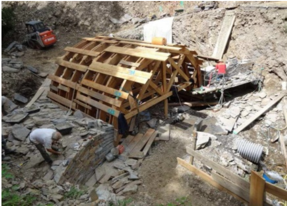
Construction des murs du pont en symétrie. Photo Maisons Paysannes de France - Prix René Fontaine ©
