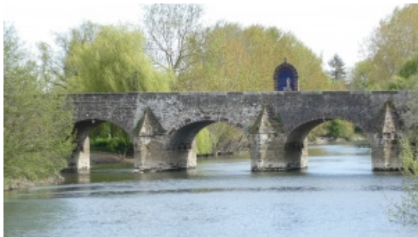
Pont de Saint-Marceau sur la Sarthe - Photo P. Dejust - Maisons Paysannes de la Sarthe.
