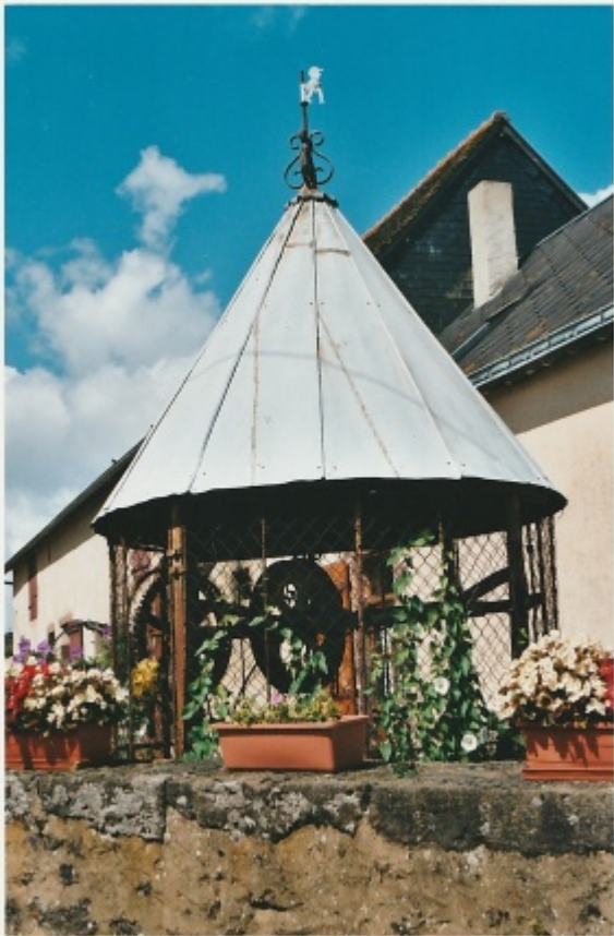
Puits avec édicule métallique, couvert de zinc, à Cures.
