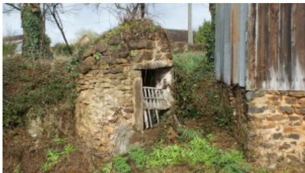
Puits avec margelle plate (en forme de chapelle) à La Bazoge.
