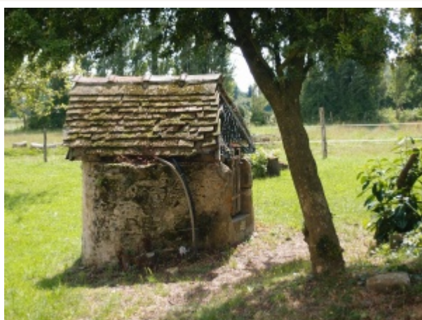
Puits couvert d'un toit à deux versants à Ballon-Saint Mars.
