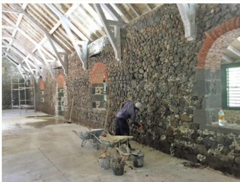
Halle intérieure de la purgerie avant jointage des pierres.
