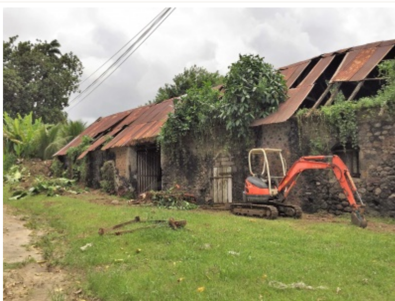
Bâtiment avant travaux
