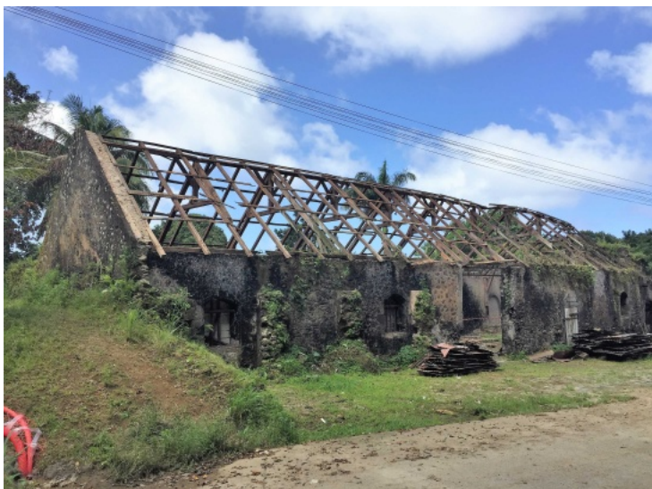
Ancienne charpente de la purgerie avant dépose. Photo Maisons Paysannes de France, Prix René Fontaine ©
