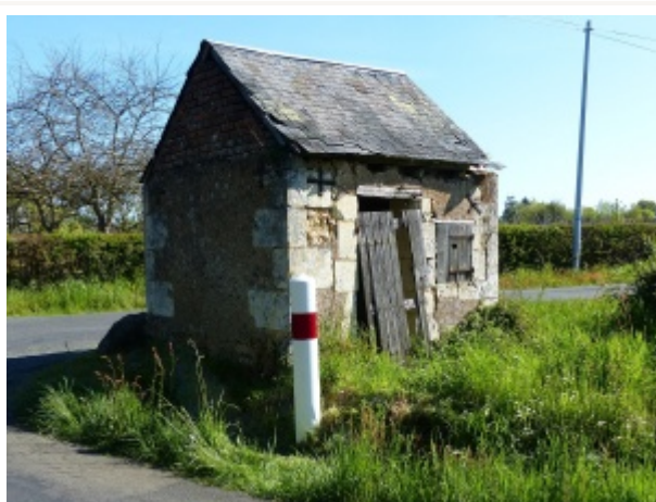
La maison de vigne avant restauration .
