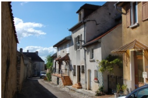
Maison de village avant restauration, située à Pesmes. Débord de toit, auvents rustiques, perron au parement de pierres et carrelage flambé.
