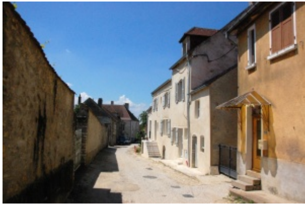
Maison de village après restauration, située à Pesmes.
