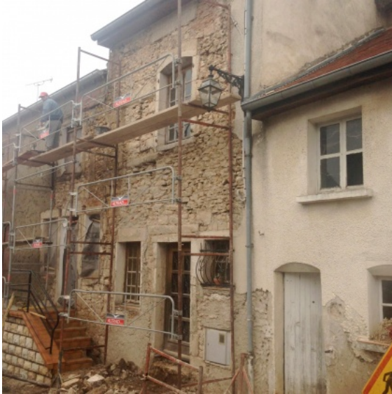
Enduit ciment retiré de la façade de la maison. Photo Fabienne Ferrut © Maisons Paysannes de France, Prix René Fontaine.
