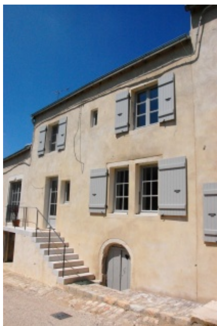
Façade d'une maison de village après restauration, située à Pesmes.
