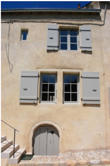
Façade après travaux. Perron réduit laissant place à un accès direct à la cave. Maisons Paysannes de France, Prix René Fontaine.
