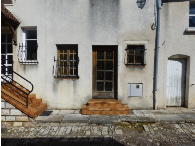
Façade de la maison avant travaux. Photo Fabienne Ferrut © Maisons Paysannes de France, Prix René Fontaine.
