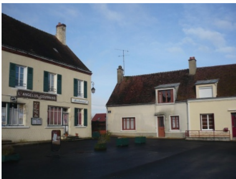
Maison avant restauration à Saint-Hilaire-sur-erre (Orne).
