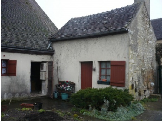
Fournil et arrière de la maison avant travaux. Photo D. & L. Guillemain © Prix René Fontaine de la Maison de Bourg.
