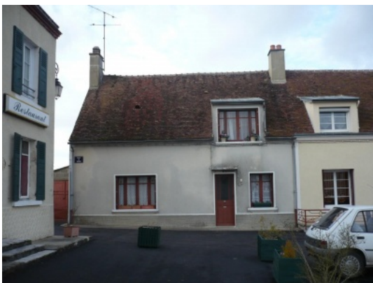
Maison avant restauration. Photo D. & L. Guillemin © Prix René Fontaine de la Maison de Bourg.
