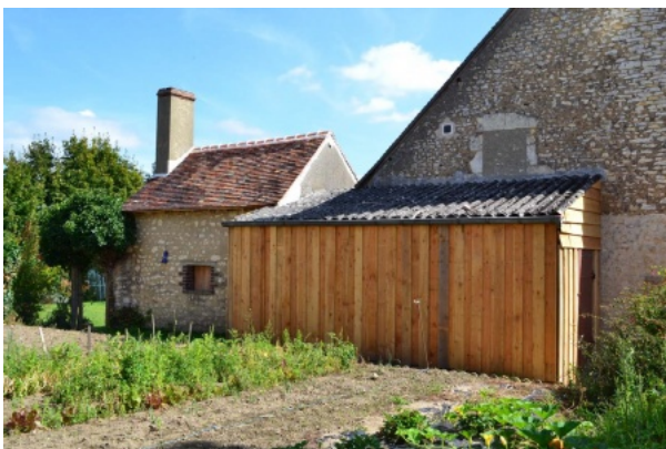
Appentis recouvert d'un bardage bois afin de mieux s'intégrer à la maison restaurée. Photo D. & L. Guillemain © Prix René Fontaine de la Maison de Bourg.
