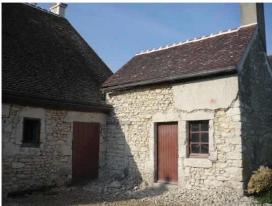
Fournil et arrière de la maison après piquetage de l'enduit ciment. Photo D. & L. Guillemain © Prix René Fontaine de la Maison de Bourg.
