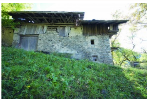
Chalet d'alpage, état avant travaux.
