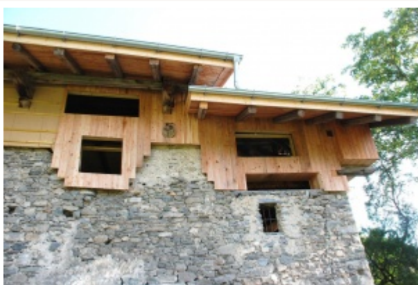
Pose du bardage en mélèze sur l'ossature bois.
