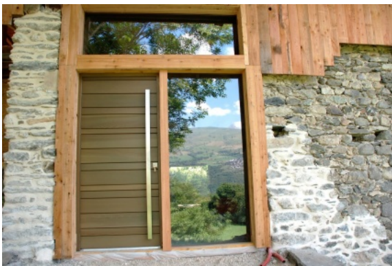
Ajout de nouvelles menuiseries ainsi que d'une porte contemporaine en remplacement de la porte de grange. Photo P. et A. Hoogewys © Prix René Fontaine, Catégorie bâti contemporain, 2015.
