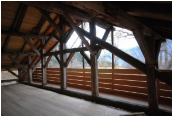
Charpente conservée et balcon restauré.
