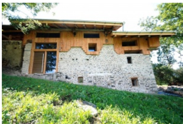
Chalet d'alpage, état après travaux.
