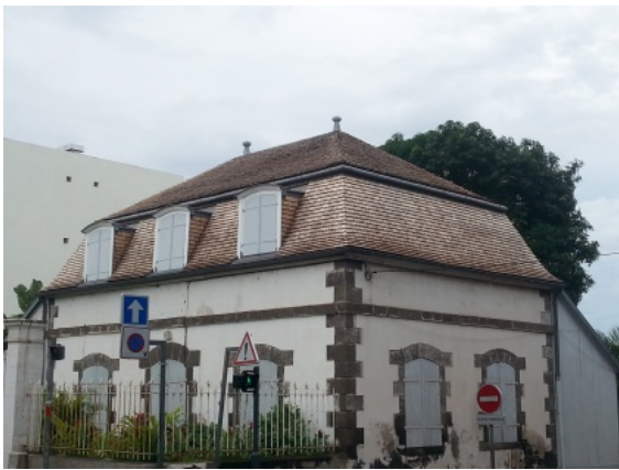
Maison Adam de Villiers après restauration de la couverture. Photo Pierre Danielczak © Prix René Fontaine 2018.
