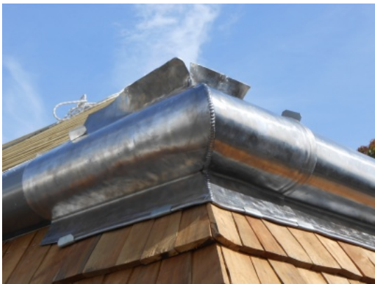
Membron en plomb recouvrant des bardeaux de tamarin après restauration. Photo Pierre Danielczak © Prix René Fontaine 2018.
