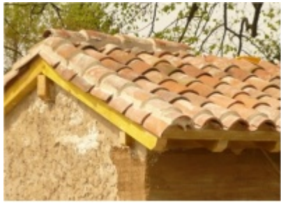
Pose tuile de rives © Pierre Forissier
