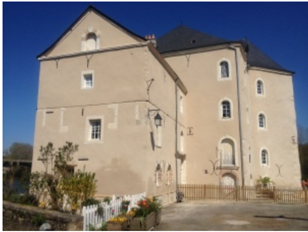
Façade ouest restaurée
