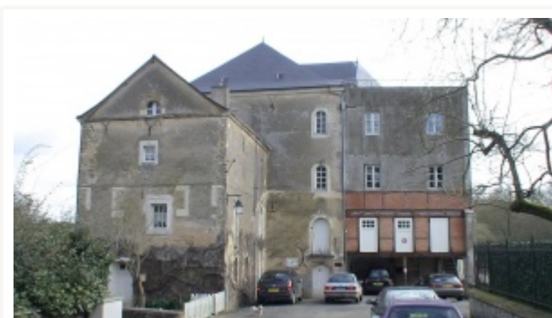
Façade ouest (côté village) en 2010 avant travaux.
