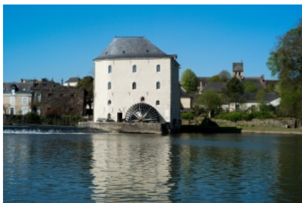
Façade est restaurée.
