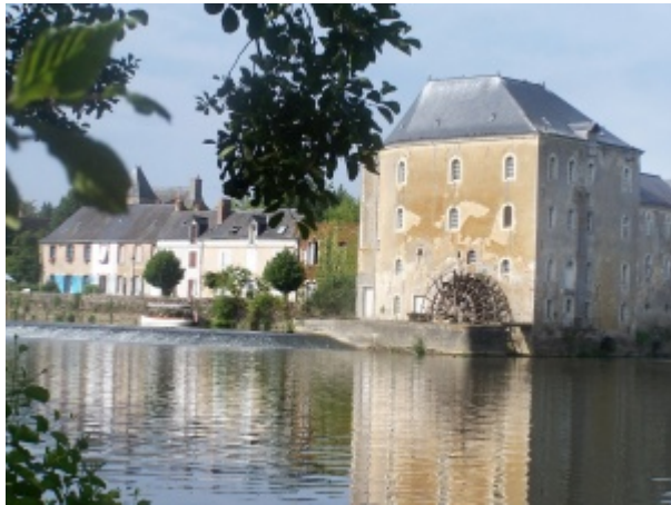
Le moulin en 2006 avant restauration, vu du pont sur la Sarthe.
