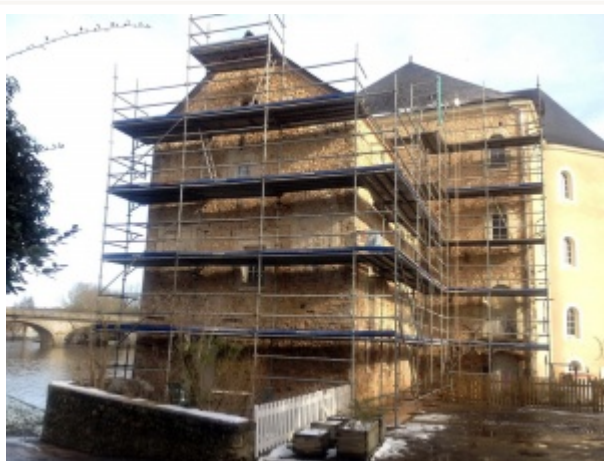
Façade ouest en travaux.
