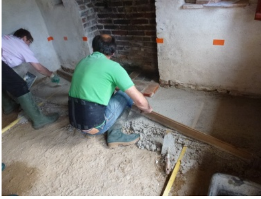
Tirage de la chape. Photo Claudie Plisson © Maisons Paysannes de France, Délégation du Loiret.
