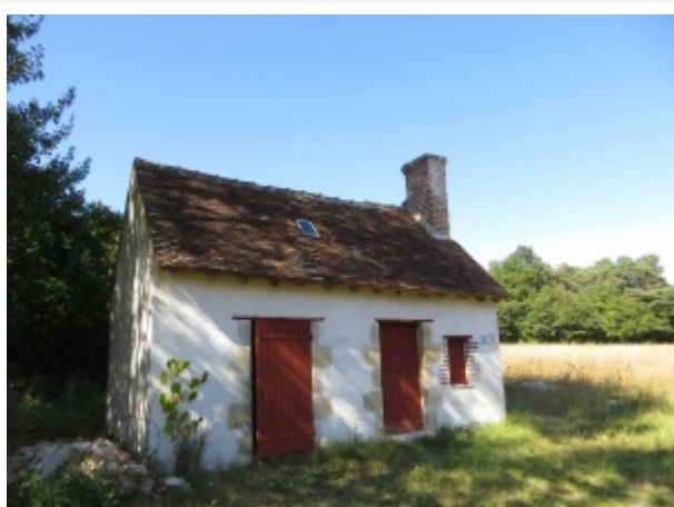
Loge de vigne après travaux de restauration.
