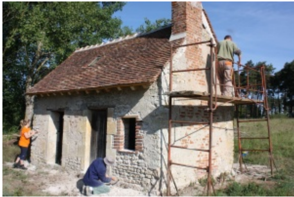
Piquetage des murs extérieurs de la loge de vigne.
