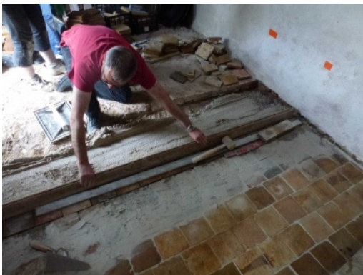
Réalisation de la chape à l'avancée avant pose de carreaux à joints décalés, coulés à la barbotine. Photo Maisons Paysannes de France © Délégation du Loiret.
