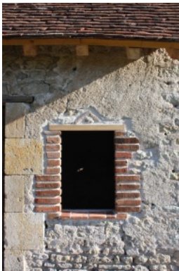
Linteau et encadrement de fenêtre restaurés. Photo Claudie Plisson © Maisons Paysannes de France, Délégation du Loiret.
