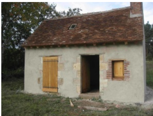
Pose des menuiseries et pose de l'enduit de finition.
