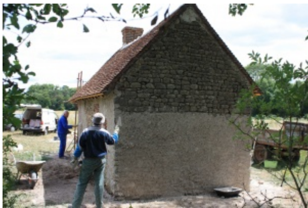
Pose du corps d'enduit sur les murs extérieurs.
