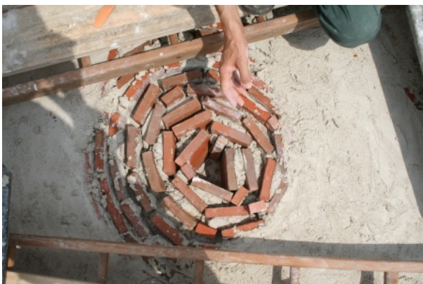
Pose des tuiles sur le sommet de la voûte aplatie du four. Photo Maisons Paysannes de France, Délégation Dordogne-Périgord ©
