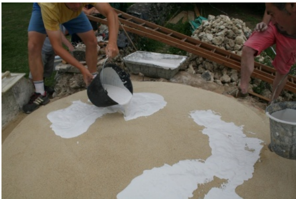
Réalisation d'un glacis en plâtre. Photo Maisons Paysannes de France, Délégation Dordogne-Périgord ©
