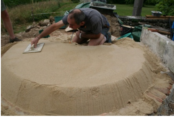
Lissage du sable du coffrage. Photo Maisons Paysannes de France, Délégation Dordogne-Périgord ©
