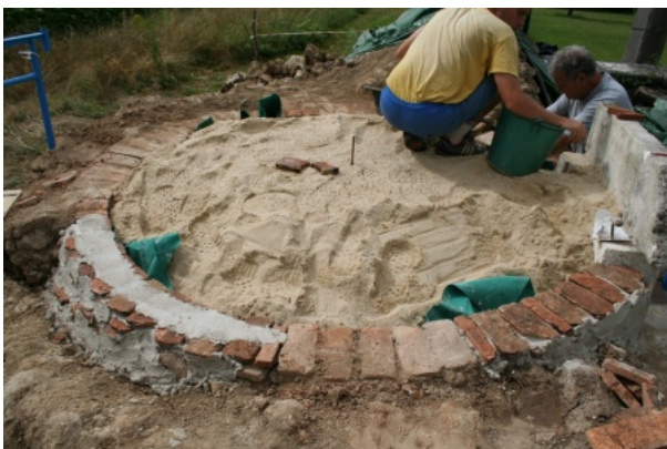
Remplissage de sable pour réaliser un coffrage à la voûte. Photo Maisons Paysannes de France, Délégation Dordogne-Périgord ©
