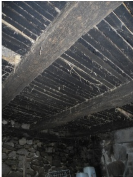
Plancher à claire-voie à l'intérieur d'un sécadou.
