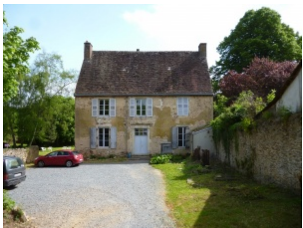
Maison avec jambages des ouvertures en tuffeau importé de la vallée du Loir - Photo François Pasquier - Maisons Paysannes de la Sarthe.
