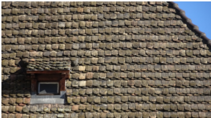
Tuiles à pose couronnée, Strasbourg
